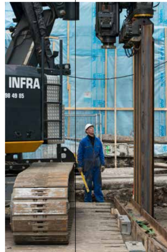
Grote foto: Nachtransport van de damwandstelling. Foto links en hierboven: Plaatsen van de damwanden. Fotografie: Co de Kruijff
